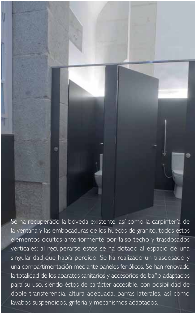
VISTA de los aseos después de la intervención
