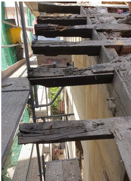
Restauración cubierta Real Colegio de Santa Isabel
