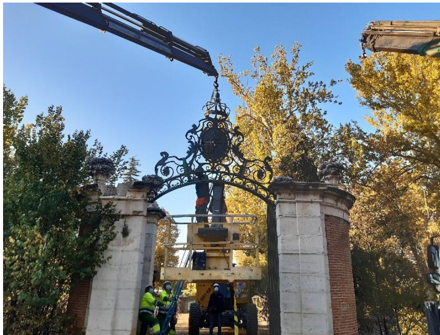
Desmontaje de la puerta del Culón Jardín de la Isla. Aranjuez
