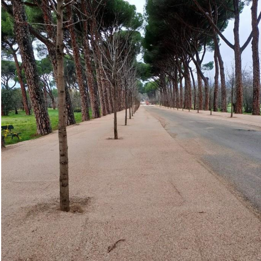
Mejora del firme en el Paseo del Príncipe. San Lorenzo de El Escorial
