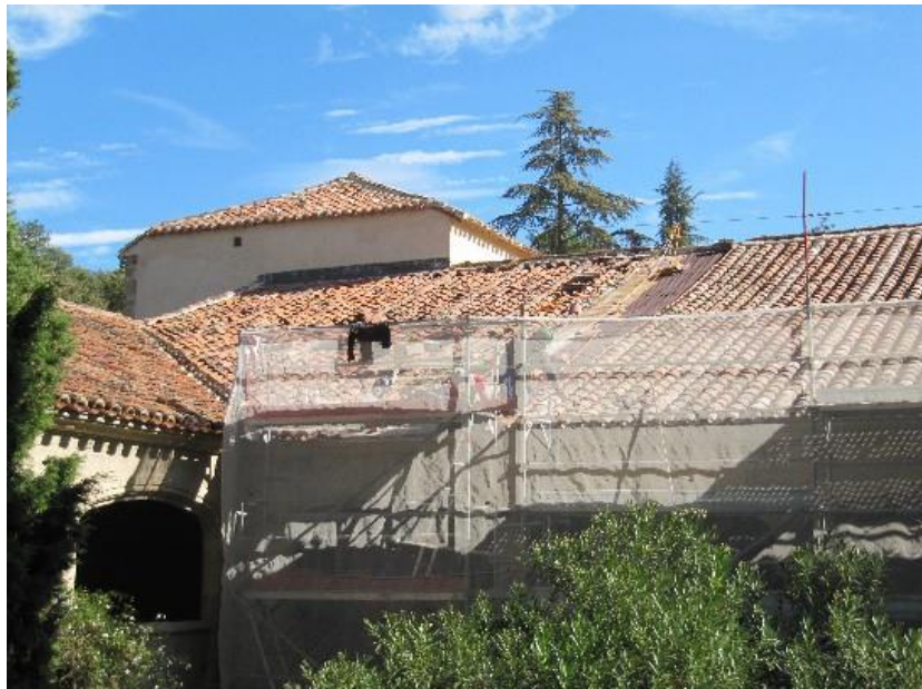
Reparación de la cubierta del Monasterio de Yuste
